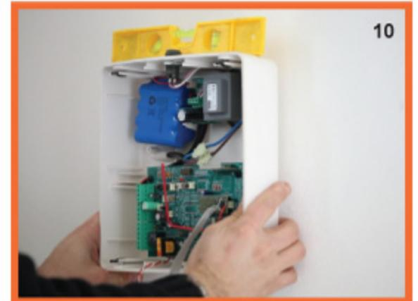
Posizionare la centrale in corrispondenza dei fori e inserire e fissare a fondo le viti relative. Foto 8-9-10
