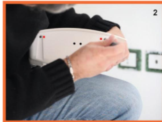
Togliere le quattro viti presenti sulla Centrale due sulla parte superiore, due sulla parte inferiore Foto 1-2
