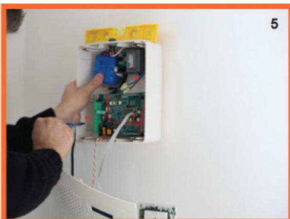
Appoggiare la centrale alla parete, tenendola parallela al pavimento (anche aiutandosi con una livella a bolla) e, tramite una matita, segnare i due punti di fissaggio. Foto 5
