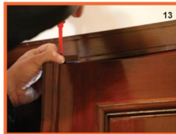
Con due piccole viti, fissare il magnete alla parte mobile della porta o finestra **Foto12-13**
