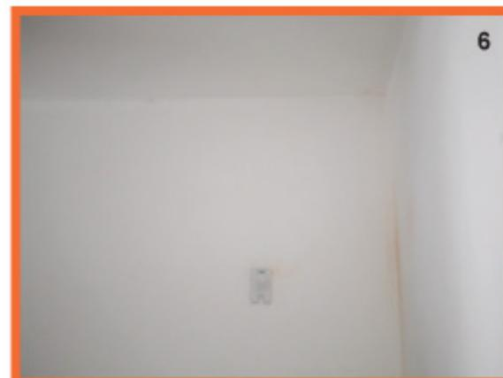
Inserire nel muro la plastica del tassello e fissare la staffetta serrando la relativa vite, si abbia cura di tenerla verticale **Foto 5-6**
