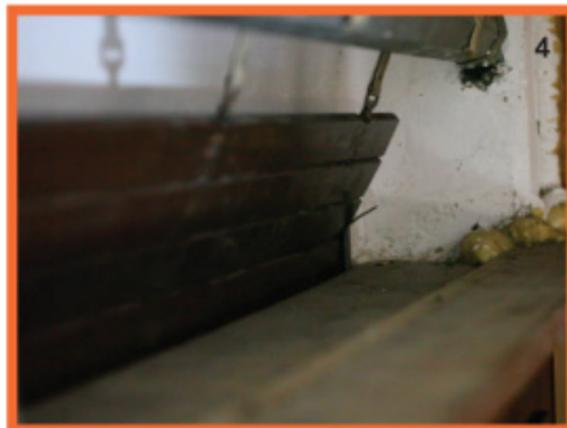
Rimuovere il pannello che copre il rotolante della tapparella posizionato sulla parte superiore del serramento e abbassare completamente la tapparella, si accede allo spazio dove dovremo eseguire l'installazione **Foto4**
