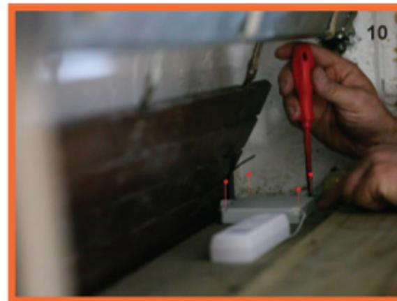
Posizionare i due componenti sul ripiano **Foto5-6** a fare avanzare lo stadio del rilevatore a cordina, fino alla parte aperta del ripiano **Foto7-8**, facendo sporgere di poco la testa di recupero **Foto9** (vista da sotto) Fissare l'unità a cordina con piccole viti autofilettanti oppure colla tipo millechiodi **Foto10**
